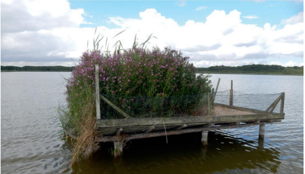
Foto 8: Insel 4 mit abgesackter Mitte und starkem Vegetationsaufwuchs – Nutzung von 2009 bis 2018. 16.07.2018.
