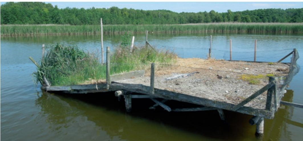
**Foto 7:** Auf Insel 2 ist ein Teil abgesackt. Hier wächst durch den Wasserkontakt höhere Vegetation auf – Nutzung von 1998 bis 2018. 15.05.2014.
