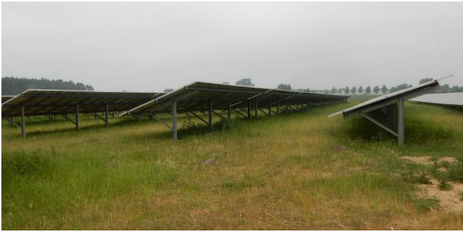
Abb. 8: Kontrollfläche Nr. 2 - PVA Güstrow 2
