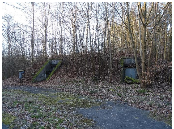
Abb. 11: Intakter Bunker innerhalb der Muna
