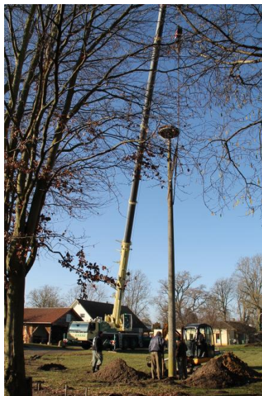
Abb. 5: Nistmastumsetzung in Hohen Spreng am 02.2.2021
