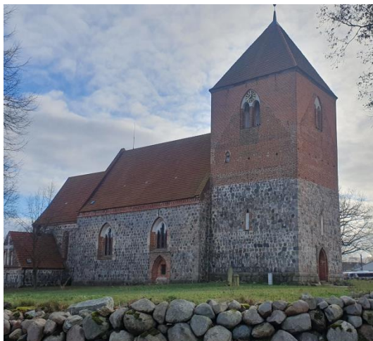
Abb.1: Kirche Lohmen mit Rüstungslöchern im Turm
