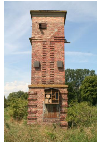
Abb. 1: Beispiel Trafostation in Hoppenrade
